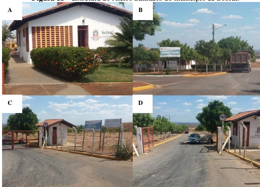
Figura 11 – Estrutura do Aterro Sanitário do município de Sobral.
