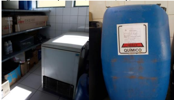
Figura 3 - Abrigo de resíduos químicos, freezer (esq.) e bombonas (dir.).
