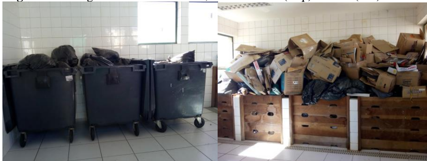
Figura 4 - Abrigo de resíduos comuns, contenedores (esq.) e baias (dir.).
